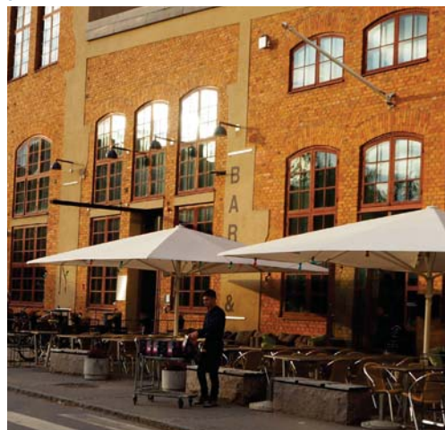
Dieselveckstaden är ett gott exempel på en byggnad som fyller en rad nya funktioner såsom klättring, biograf och möteslokaler
